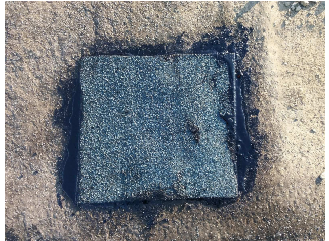
foto/2/ Pohled na zapravenou sondu S1
