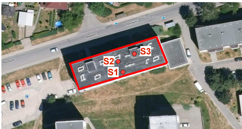
obr. /1/ Situace (červeně vyznačená předmětná střecha objektu a jednotlivé sondy)
