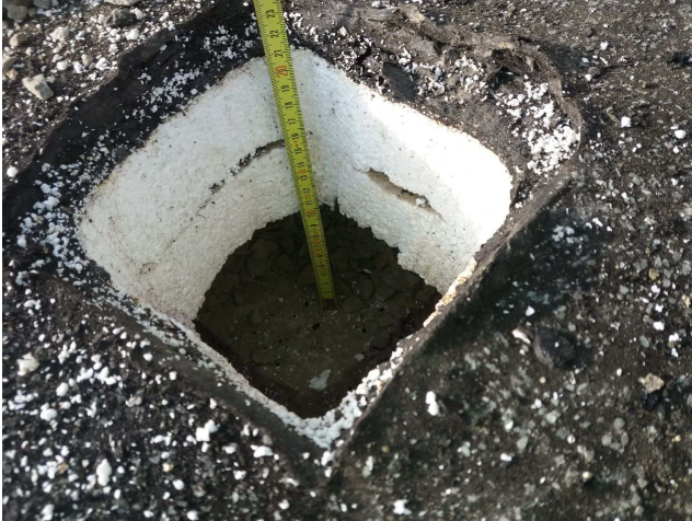
foto/3/ Pohled na provedenou sondu S2
