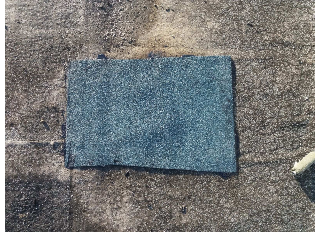
foto/4/ Pohled na zapravenou sondu S2
