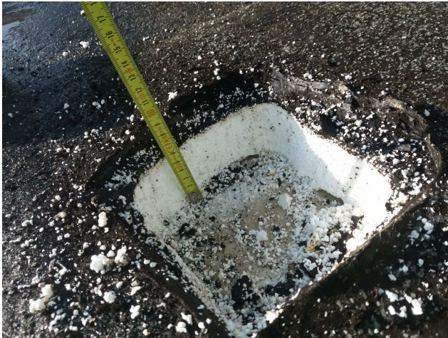
foto/5/ Pohled na provedenou sondu S3
