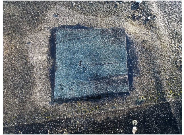
foto/6/ Pohled na zapravenou sondu S3
