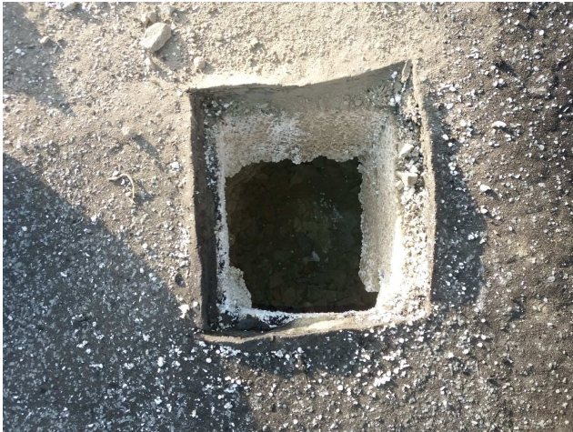
foto/1/ Pohled na provedenou sondu S1
